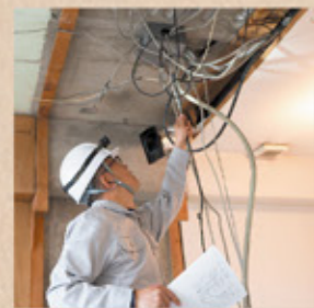
設備入替工事
