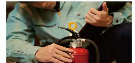
「総合点検」では消防用設備機器の全部、または一部を実際に作動させ、異常の有無などを確認します。内容としては、機器点検にさらに確認項目が追加されたものといえます。機器点検は6カ月ごと、総合点検は1年に1回実施し、その結果を特定行政庁に報告することが義務づけられています。
