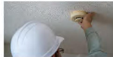
「機器点検」では、設備が適切に配置されているか、損傷はないか、誰がみてもわかるかなどの目視点検をはじめ、感知器やポンプなどの一部の設備が正常に作動するかの確認を行うのが基本です。
